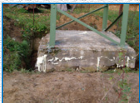
Zaptivanje i ojačavanje starog betonskog temelja
