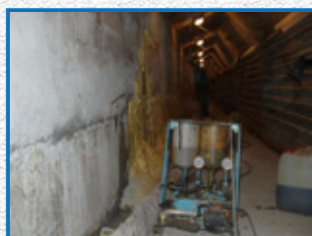
Zaptivanje prodiranja vode u tunel brane
