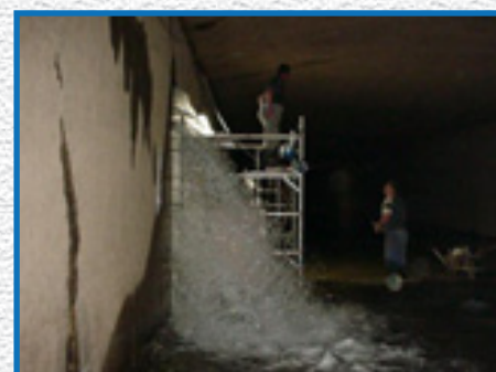
Zaustavljanje prodiranja vode u galeriju brane
