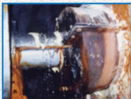
Injektiranje vodene barijere u rudnicima uglja u cilju sprečavanja proticanja vode kroz barijeru. Upotrebljeni materijal – Geopur
