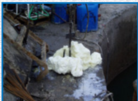
Zaustavljanje proticanja vode kroz telo brane
