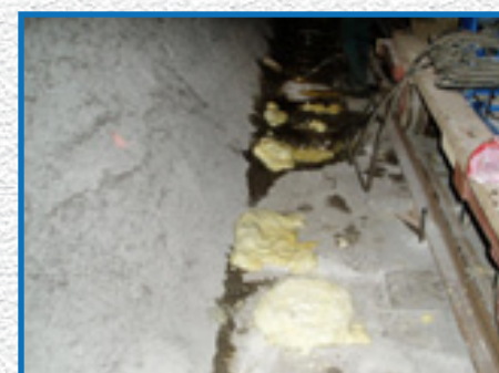
Zaustavljanje prodiranja vode u tunel metroa
