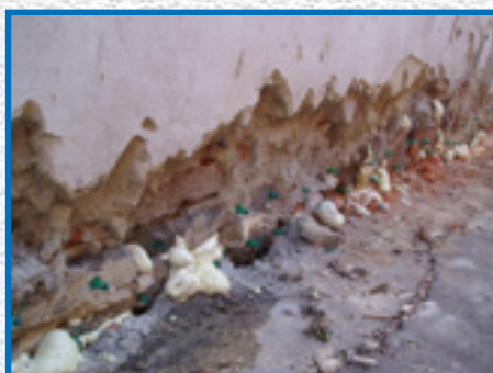
Zaptivanje i ojačavanje zidanih konstrukcija
